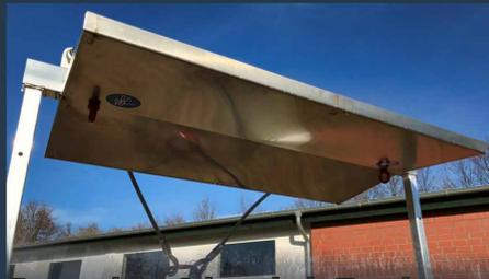
Formstabilisiertes Schutzdach. Zugelassene Anschlagpunkte für persönliche Schutzausrüstung (PSA)
